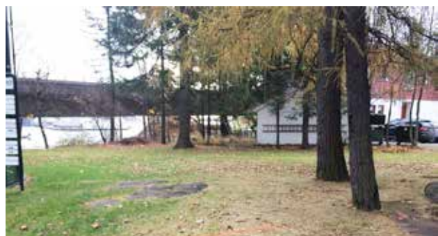
Før arbeidet begynte i slutten av desember 2016.
